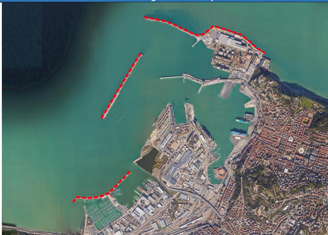
Porto di Ancona – Lunghezza tratto esposto 3.600 m
