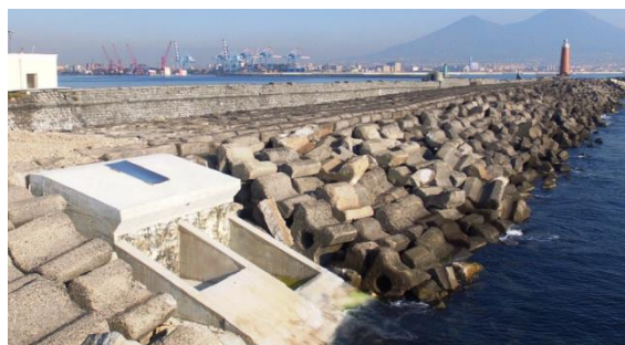
Figura 35 - Progetto DIMEMO (Diga Marittima per l'Energia del Moto Ondoso)
