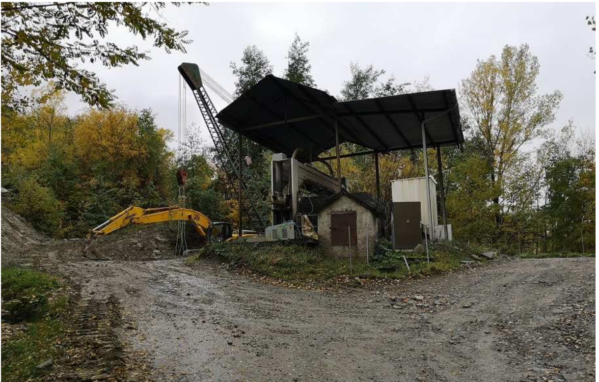
Foto 10 – La foto mostra l’impianto monolama ripreso dall’ingresso dal basso dell’area di cava, subito dietro si intravede l’impianto di decantazione delle acque a circuito chiuso del piccolo impianto di segazione.
