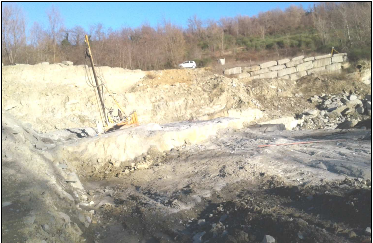
Foto n. 4 – Vista opposta alla precedente dalla base del piazzale di scavo verso monte; si osservano al centro i banchi in coltivazione e si apprezza il limitato sviluppo in altezza dei fronti di scavo.
